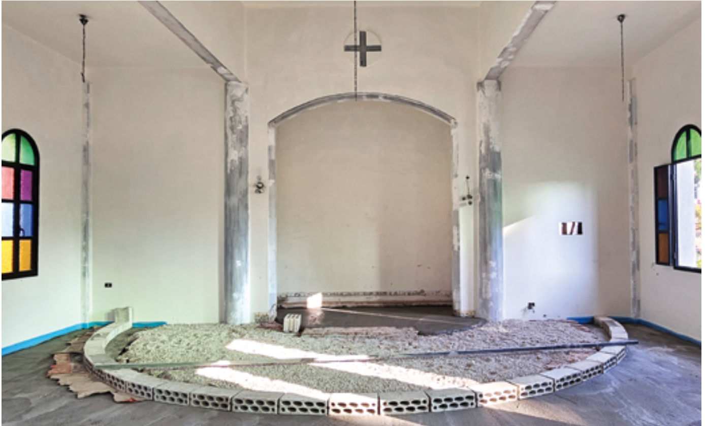
Bei der Instandsetzung der Kirche wird mit lokalen Handwerksbetrieben zusammengearbeitet
