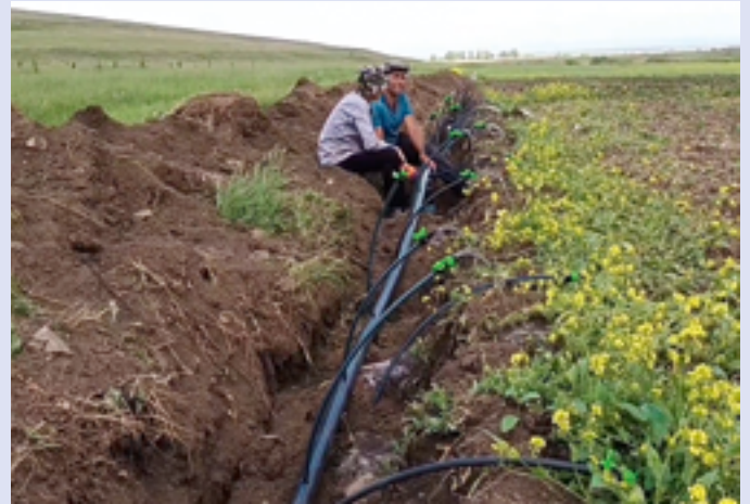
Installation des Bewässerungssystems
