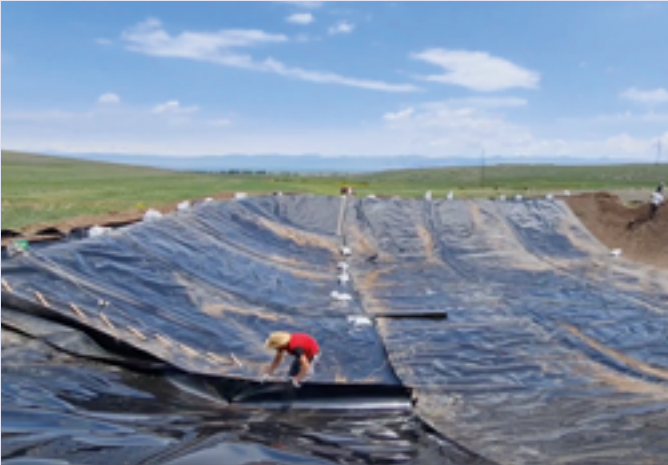
Anlegen eines Wasserbassins im Hochland Armeniens
